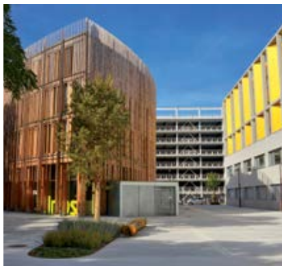
Bâtiment B © P. Gerard/LVAN
