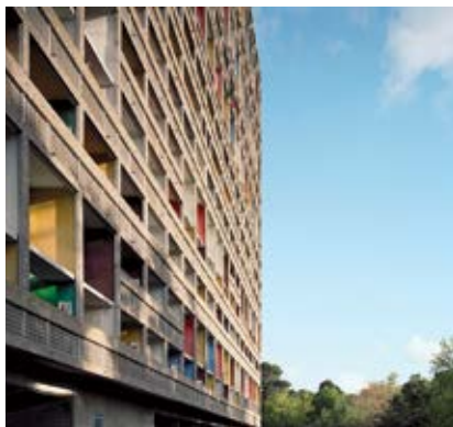
Maison Radieuse Le Corbusier © A. Tezenas/LVAN
